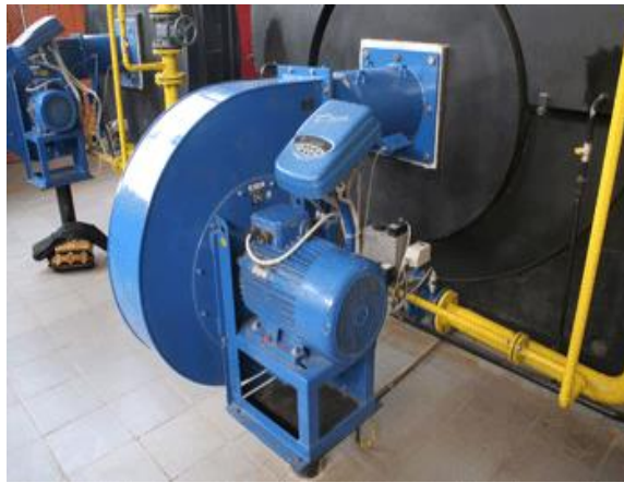
Рисунок 1– Газовий пальник типу "DAVA" зі змінним навантаженням
