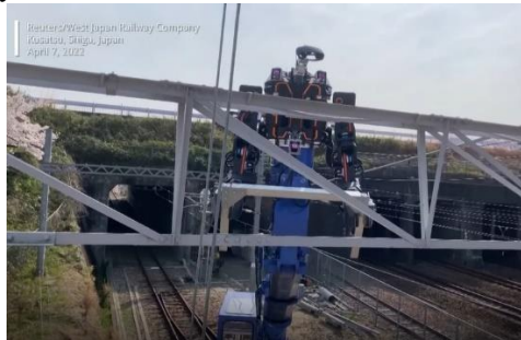
Рис. 2. Робот для ремонту важкодоступної інфраструктури, Японія [3]
