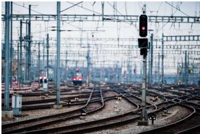
Рисунок 5.1 – Загальний вигляд вхідної горловини залізничної станції
