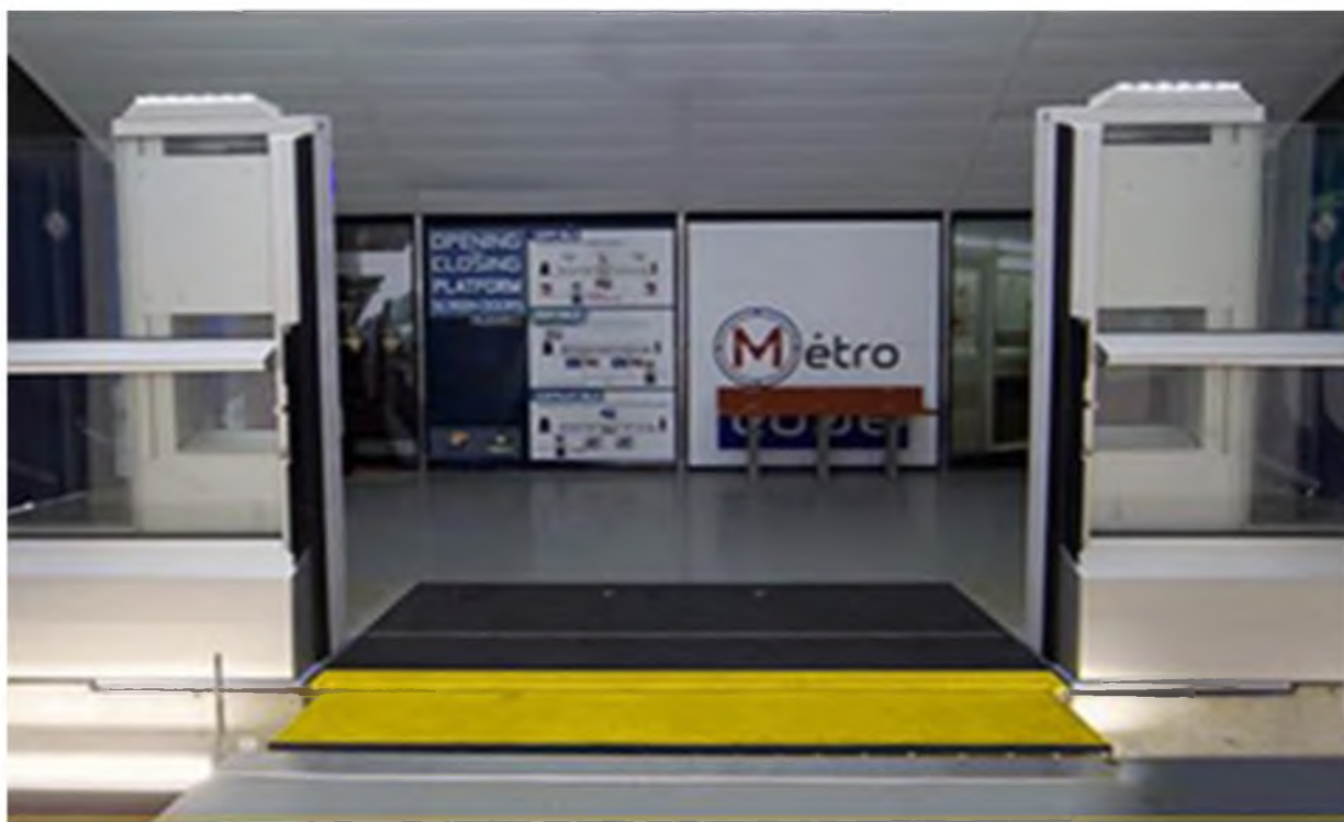
Рисунок 1.3 – Конструкція скляного огородження для пасажирів з обмеженими фізичними можливостями
