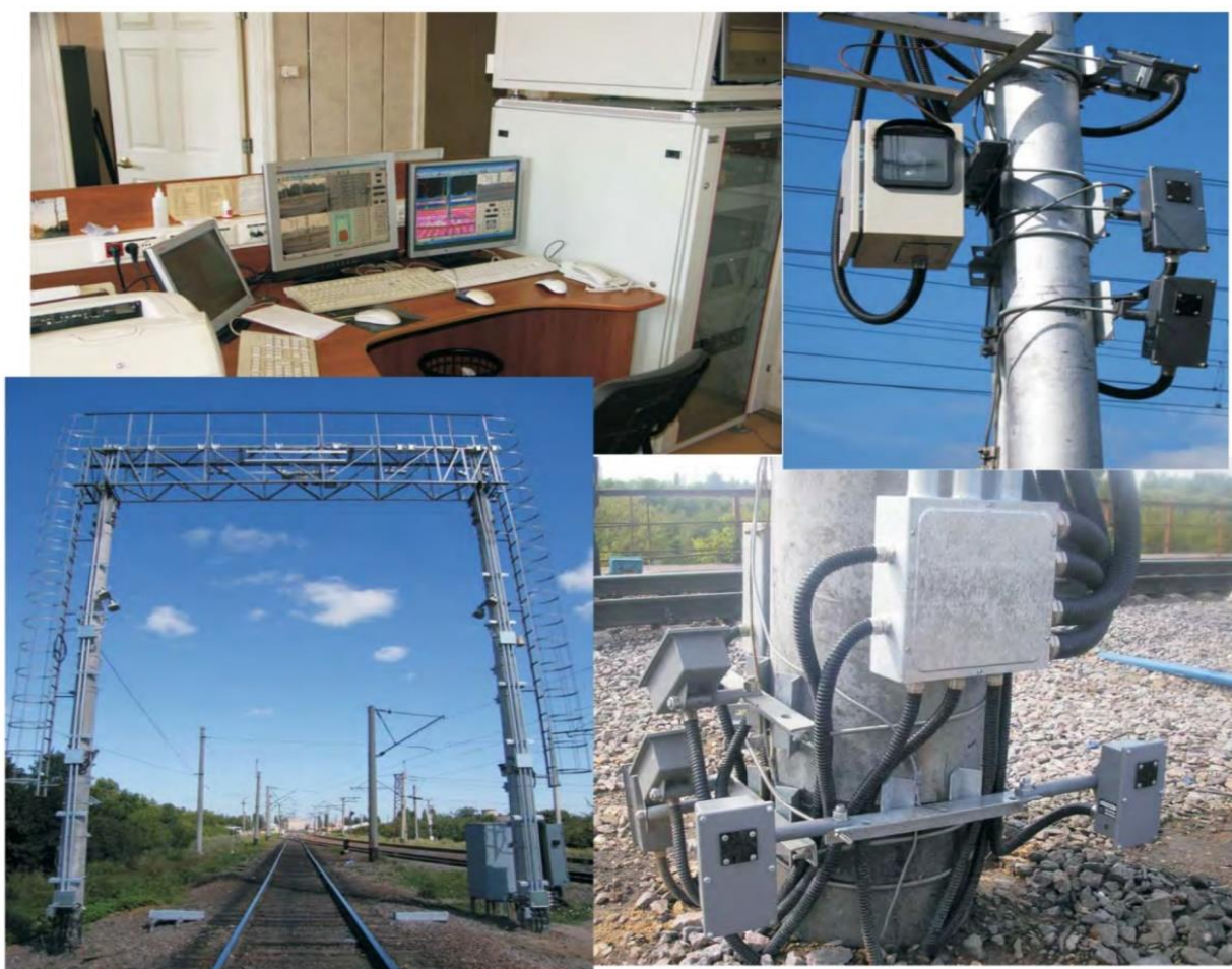
Рисунок 4.1 – Загальний вигляд габаритних воріт
