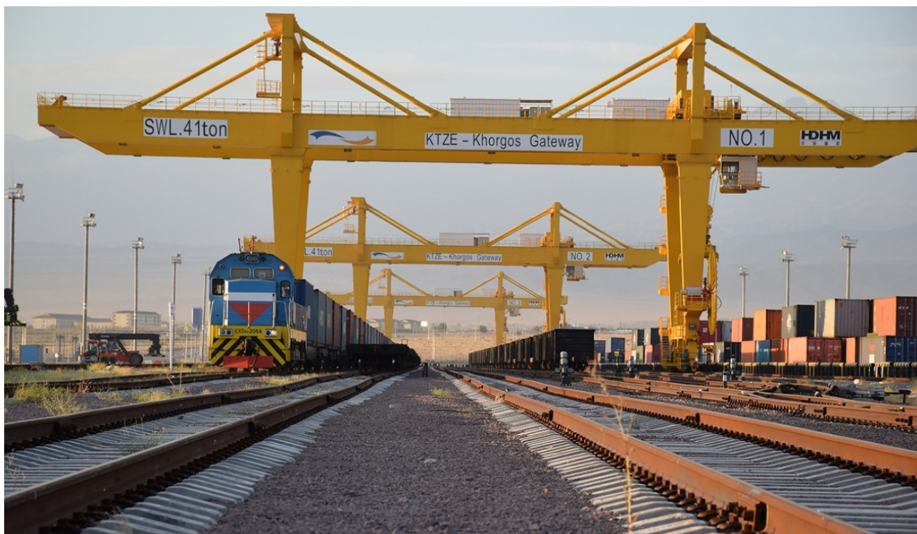
Рисунок 4.4 – Інтермодальний комплекс на станції Мостиська-2
