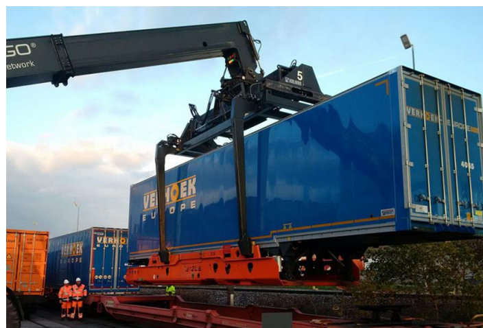
Система навантаження контейнерів та напівпричепів RoadrailLink (r2L)
