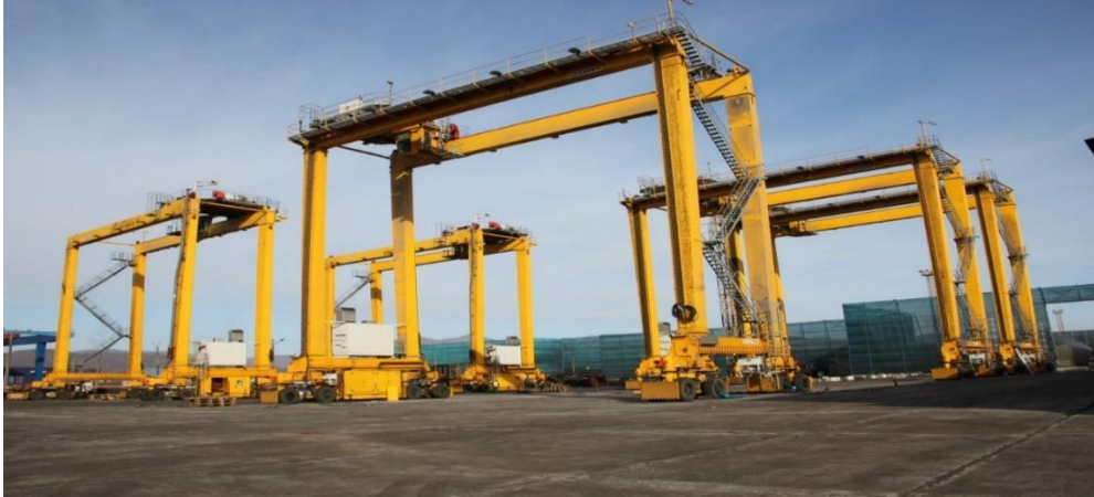
Рисунок 3.12 – Пневмоколісні крани типу RTG компанії «Liebherr»
