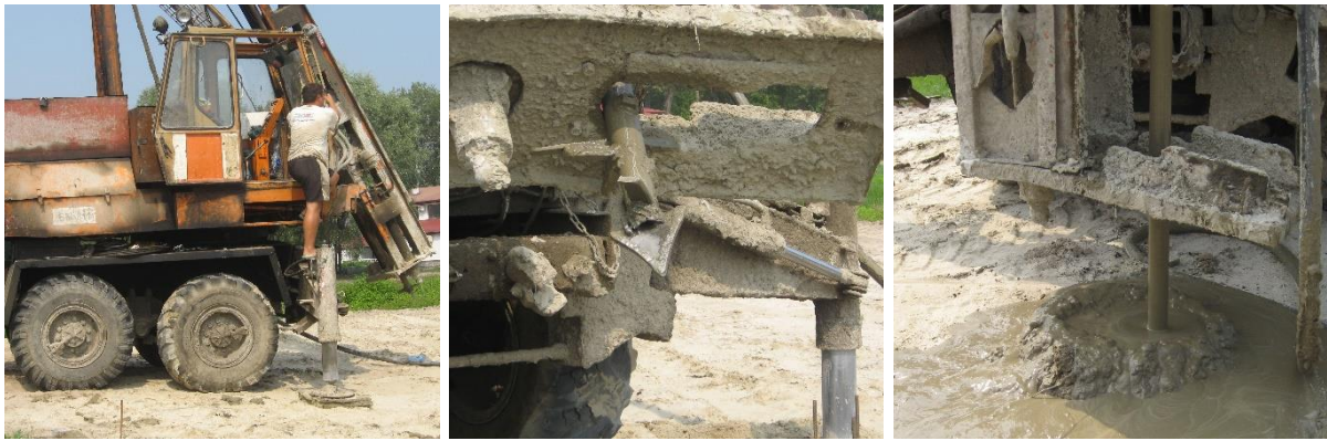
Рисунок 2 – Бурозмішувальна технологія виготовлення цементогрунту
