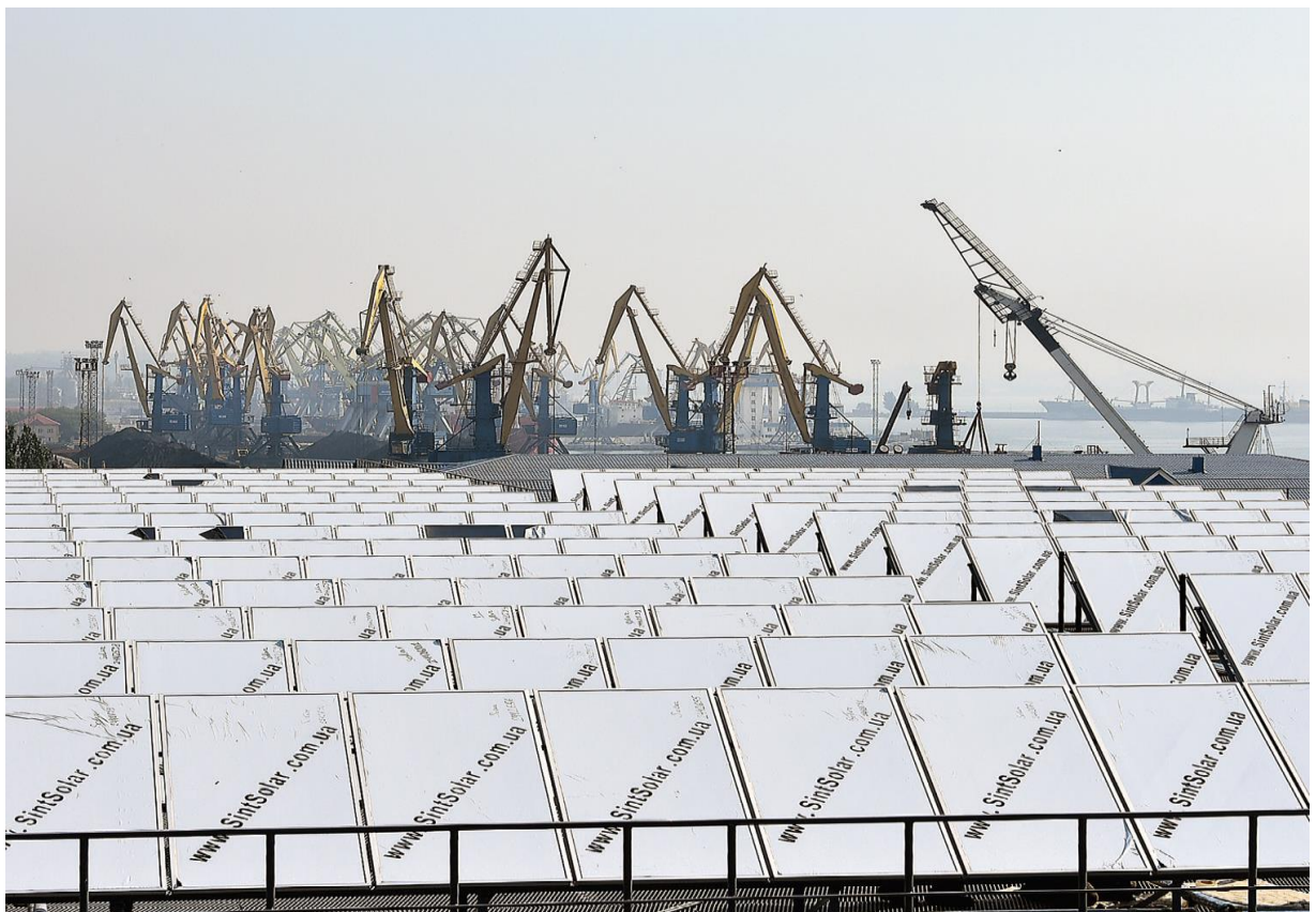
Рисунок 3.16 – Установка геліосистем на даху будівлі вуглесортувальні в Маріупольському порту (2016 рік)
