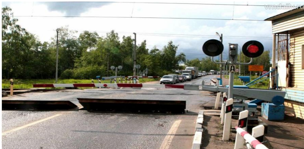
Рис. 1. Пристрої загородження переїзду – бар'єри
