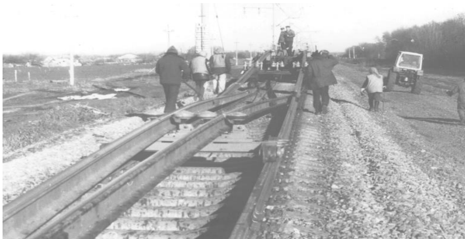
Рис. 5. Укладання зварних плітей безпосередньо з рейкового поїзда
