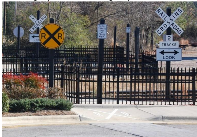
Рисунок 1 - Залізничний переїзд із різноманітними пасивними пристроями, включаючи огорожу та знаки. Джерело: Flickr - Дональд Лі Пардью (2010)
