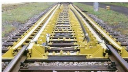
Рис. 2. Ділянка колії для зміни ширини візків
