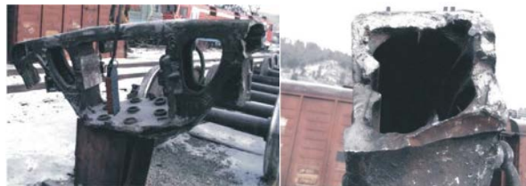
Рис. 2. Злом бокової рами через невиявлену тріщину
