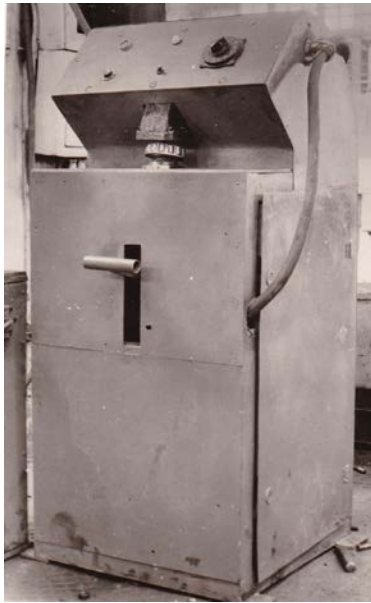
Рис. И.15 Індукційна установка для нагріву підшипників редукторів типу Ц2У (1973 р.)
