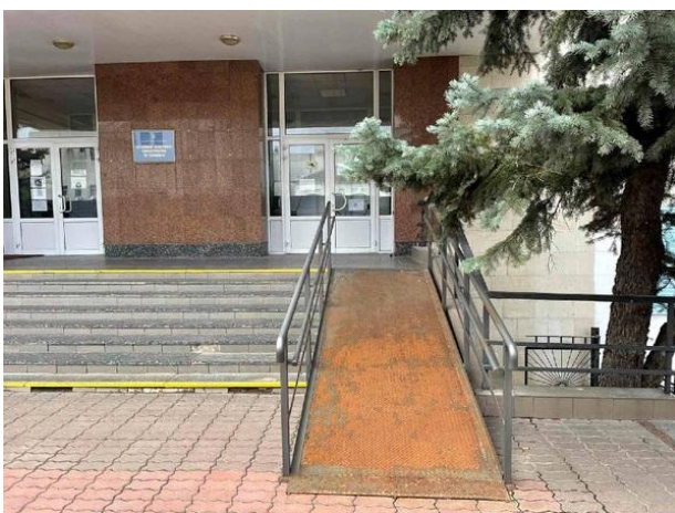
Навчальний корпус вул. Івана Огієнка, 19
